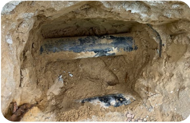
Freigelegtes Druckrohr eines 110-kV-Gasaußendruckkabels mit den charakteristischen Einbaumerkmale.
