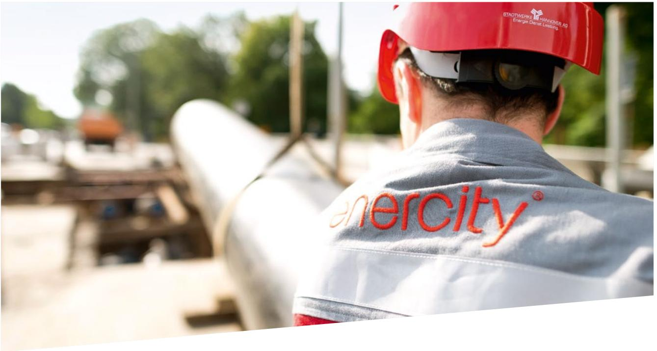
Die Versorgungsleitungen müssen in der Baugrube so aufgehängt, abgestützt oder befestigt werden, dass eine äußere Krafteintragung ausgeschlossen ist. An den Masten der Straßenbeleuchtung darf nichts befestigt werden.
